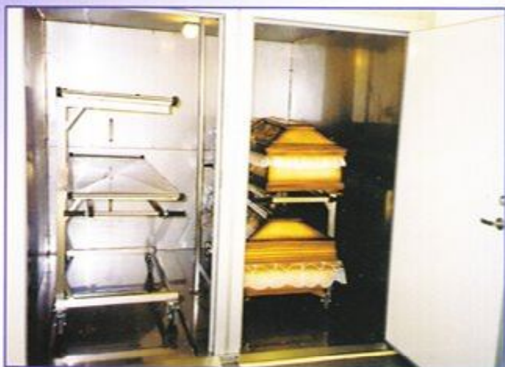
Komora chłodnicza w systemie wózkowym na 5 ciał (2 trumny i 3 tace), 2002 r., Włocławek.
