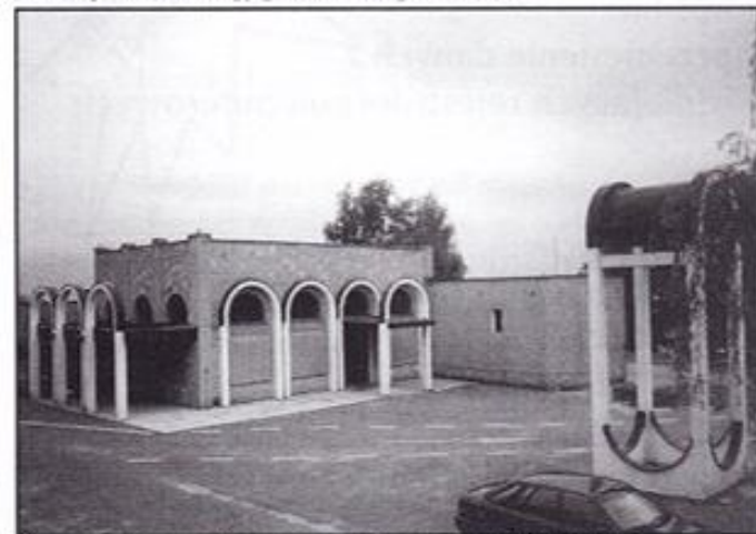
Dom przedpogrzebowy na cmentarzu przy ul. Rudzkiej.
