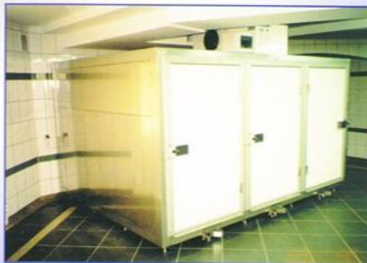
Komora chłodnicza na 6 ciał (uniwersalnie w trumnach lub na tacach), w systemie regałowym, cmentarz komunalny w Słupsku.
